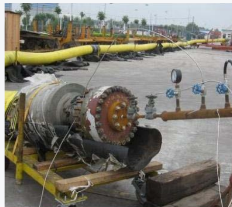
При испытании под давлением
