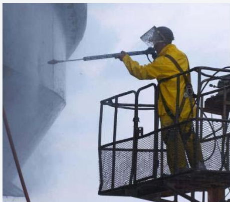
Очистка стальной поверхности
