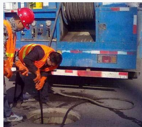
Прочистка канализационных труб
